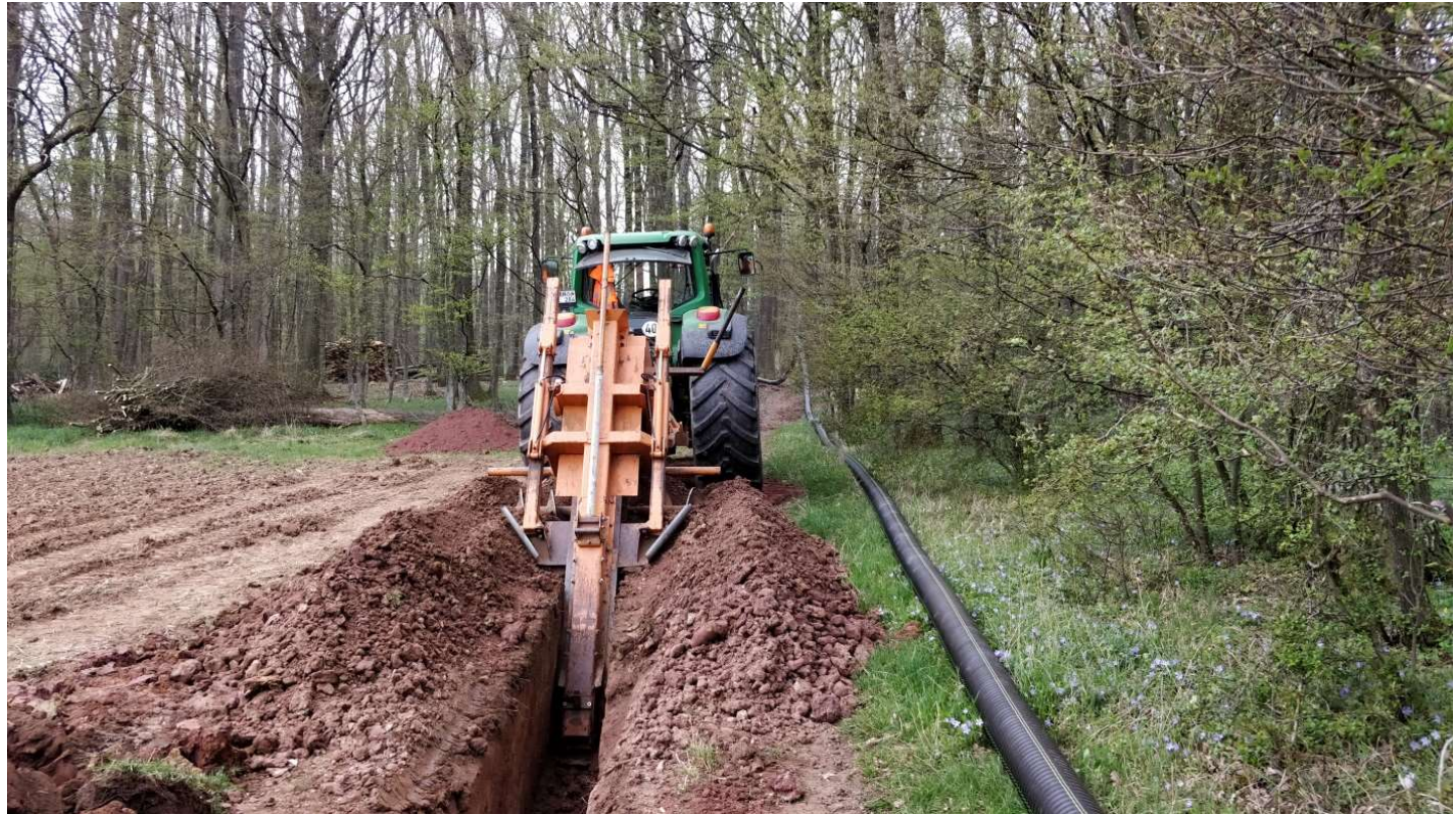
Offenes Bauverfahren mit der Grabenfräse
