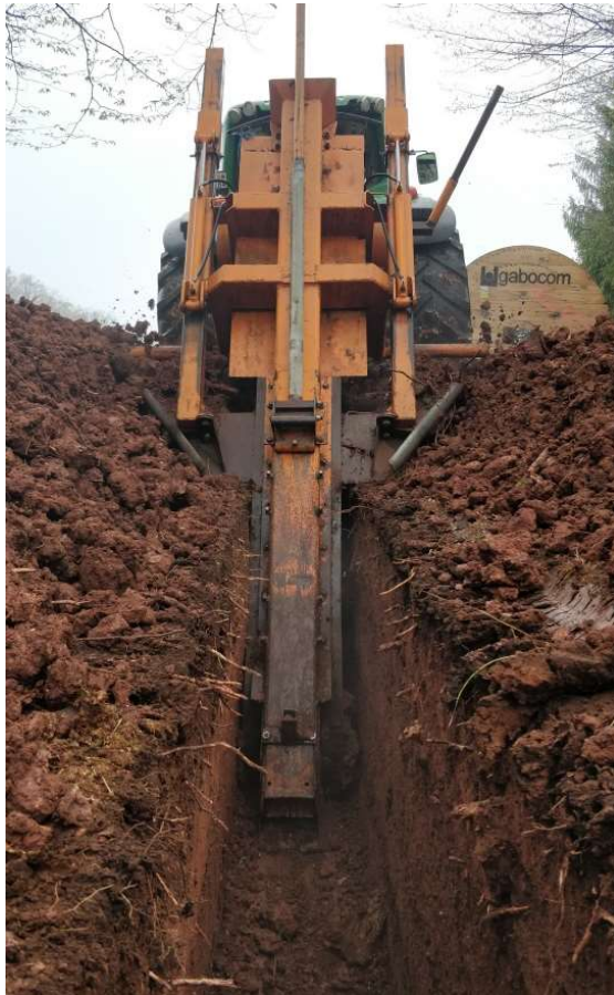
Offenes Bauverfahren mit der Grabenfräse
