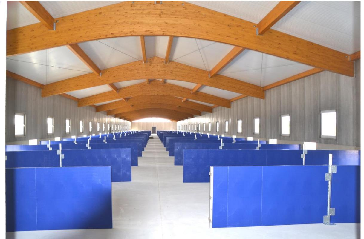
Kuhstall, Tragwerkskonstruktion aus Stahl/Leimholz mit Zugband
