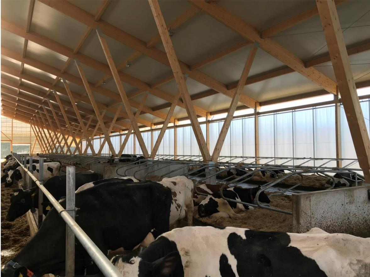
Außenklima-Kuhstall mit V-Streben, Einhängepfetten und Sandwich-Dacheindeckungen, Chat-Dach-First
