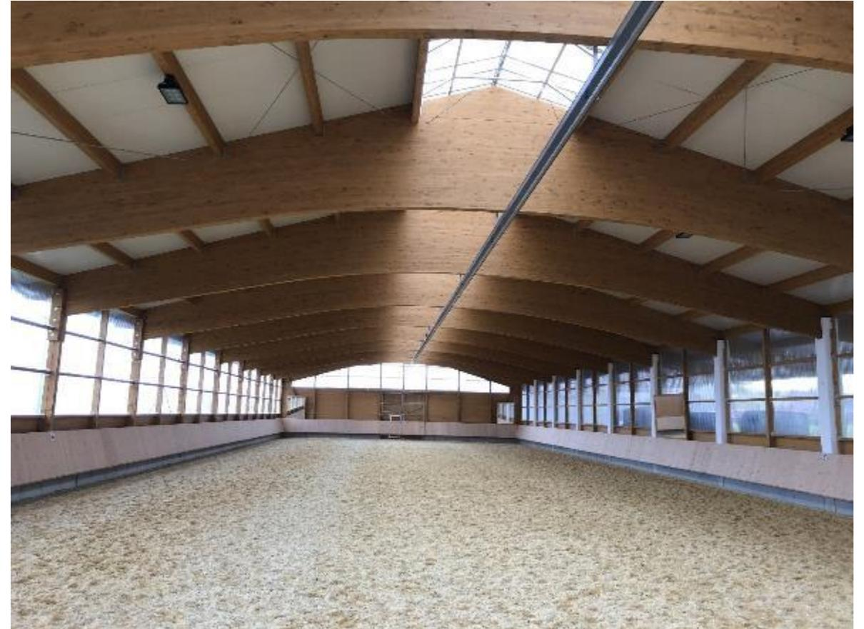
Reithalle mit Biegeträger und einseitig eingespannten Stützen
