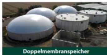
Doppelmembranspeicher
