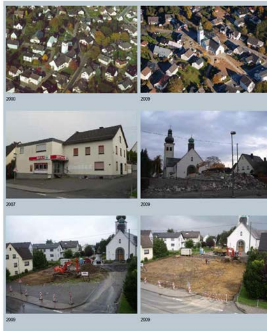
Abb. 6.25: Der Kirchplatz in Hünsborn vor, während und nach dem Abriss (Quelle: PASTORALVERBUND BIGGETAL (Hrsg.), 2010: Galerie Kirchplatz, Stand: 2010-04-29, http://pastoralverbund-biggetal.de/cms/component?option=com_ponygallery/Itemid,51/func.viewcategory/catid,1/ )
