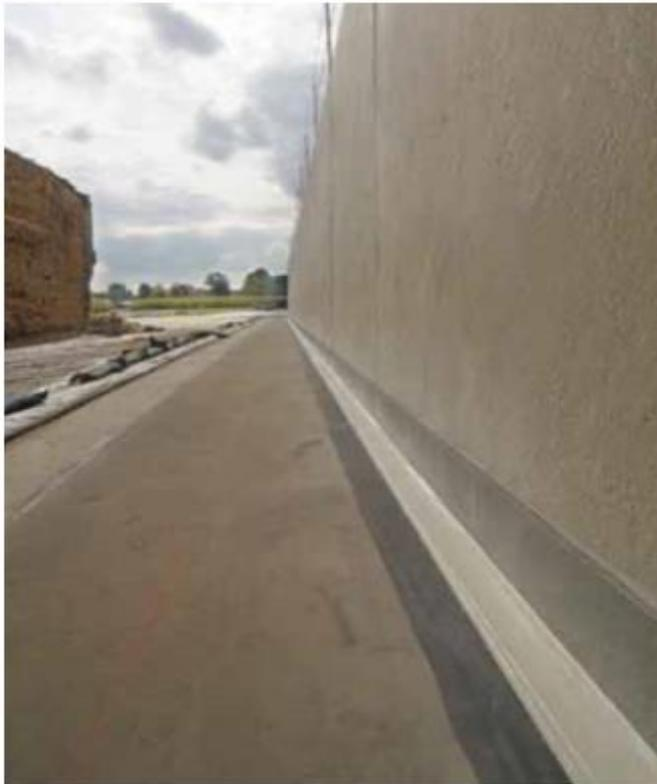
Das Abdichtungssystem Triflex ProDetail zeichnet sich unter anderem durch seine chemische Beständigkeit gegen Säuren wie z. B. Silagesäfte aus. Bereits nach vier Tagen konnten die Sanierungsarbeiten abgeschlossen werden.
