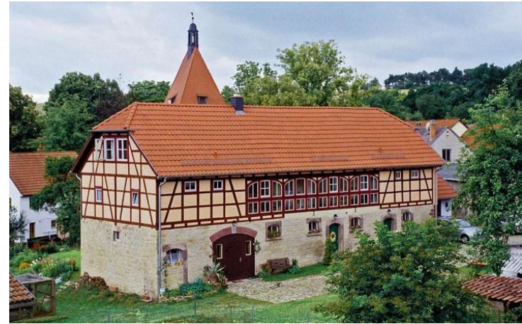
Scheunenumbau Tiefenbrunn Quelle: Dachverband-Lehm-e.V.
